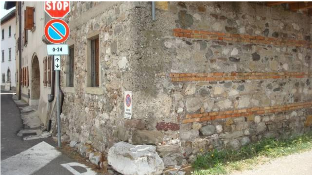
Dettaglio della casa di Dino. Questo è un esempio tipico di rifacimento del post terremoto del 1928. La conservazione di un pezzo del vecchio muro con il grosso sasso delle fondamenta a livello di strada. Gli angoli in tufo squadrato. Il muro nuovo con le righe di consolidamento in mattoni pieni. L'inserimento dei cordoli in cemento armato. Nonostante che questa tecnica costruttiva possa sembrare "naïf" rispetto alle tonnellate di ferro e di calcestruzzo delle nuove costruzioni anti sismiche, tutte le case di Caneva costruite in questo modo hanno resistito perfettamente al terremoto del 1976. Come questa senza una crepa. GV
